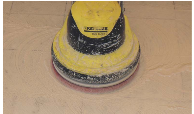
Polering af gulv
