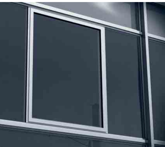
Schwimmendes Fenster als gestalterisches Element Floating window as a design feature
